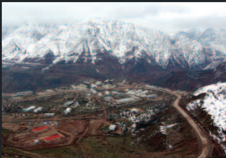
Место строительства будущей Рогунской ГЭС.
