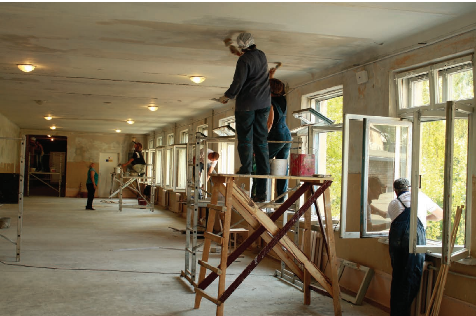
Ремонт, що триває в горлівській школі № 14. Школа була пошкоджена в результаті обстрілу в серпні 2015 року.
