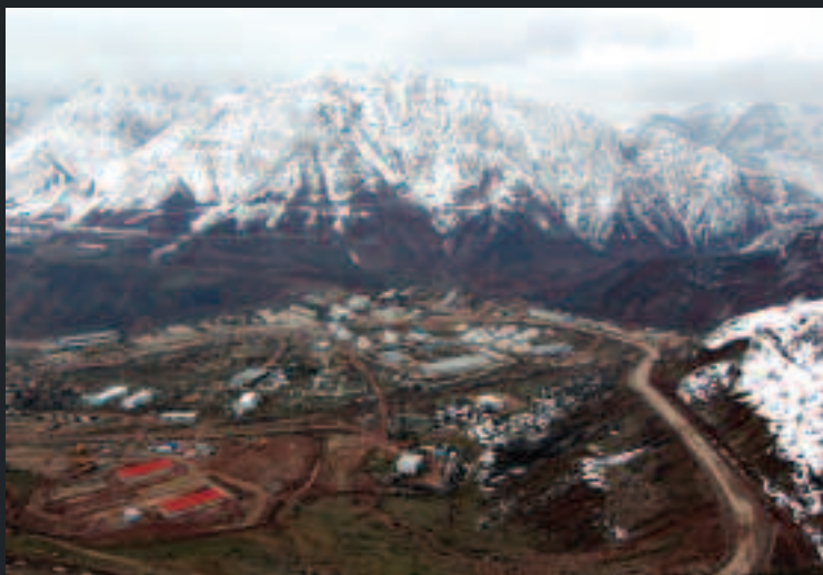
Место строительства будущей Рогунской ГЭС.
